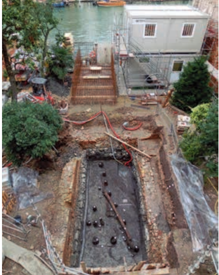
7. Parte di un “cassero a riva” rinvenuto all’interno del giardino di Palazzo Bacchini delle Palme (foto Marco Bortoletto)
