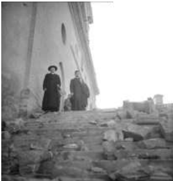
9. La cattedrale di Ortona severamente colpita dai bombardamenti (WWII, DA Series, DA-05128-F, "War damaged cathedral in Ortona, Italy", 12 gennaio 1944)
