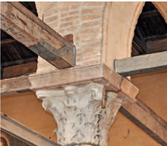
9. Torcello, chiesa di Santa Maria Assunta, restauri 1929-1938. Peduccio delle arcate del lato destro con le armature predisposte per il nucleo in calcestruzzo armato che fissa le staffe metalliche delle travi-catene (giugno 1936) (SABAPVe, AF, neg. 6521, part.)
