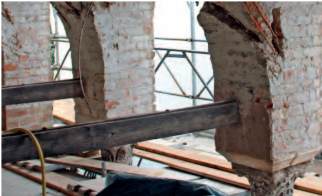
15. Torcello, chiesa di Santa Fosca. Peducci del lato nord del portico. Si vedono le barre chiodate sopra le catene lignee dell'intervento di Rupolo del 1908-1915 (2014, foto Studio Tocchi)
