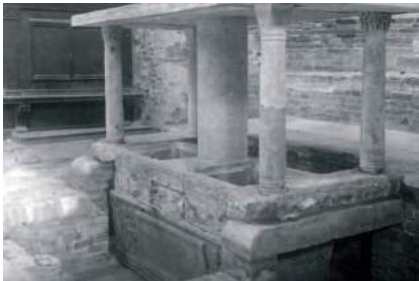
3. Altare maggiore della basilica di Santa Maria Assunta, Torcello. Una fase dell'intervento di "liberazione" dalla facies barocca (Iuav, AP, FFT, NP 066847)
