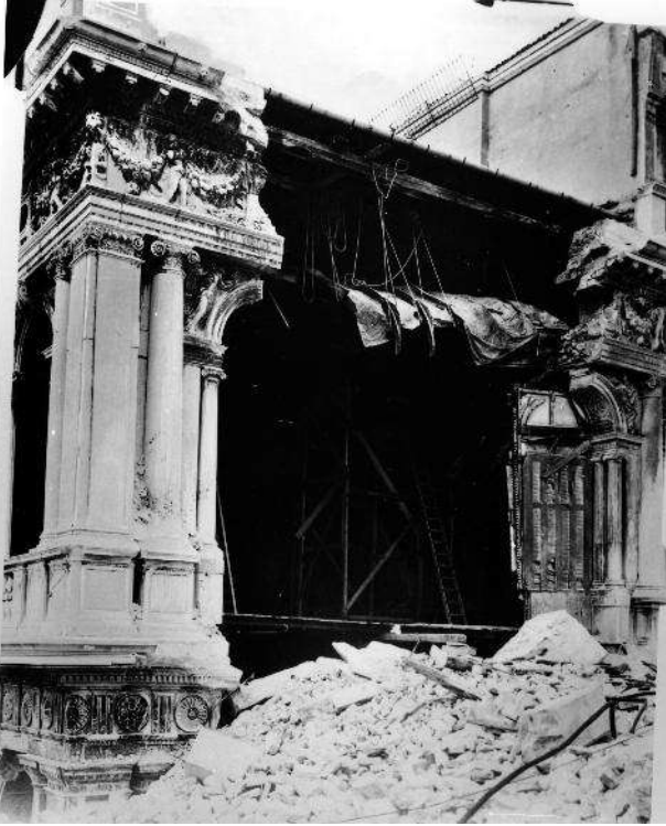
3. Libreria sansoviniana, prospetto verso Piazza San Marco dopo il crollo del campanile.
